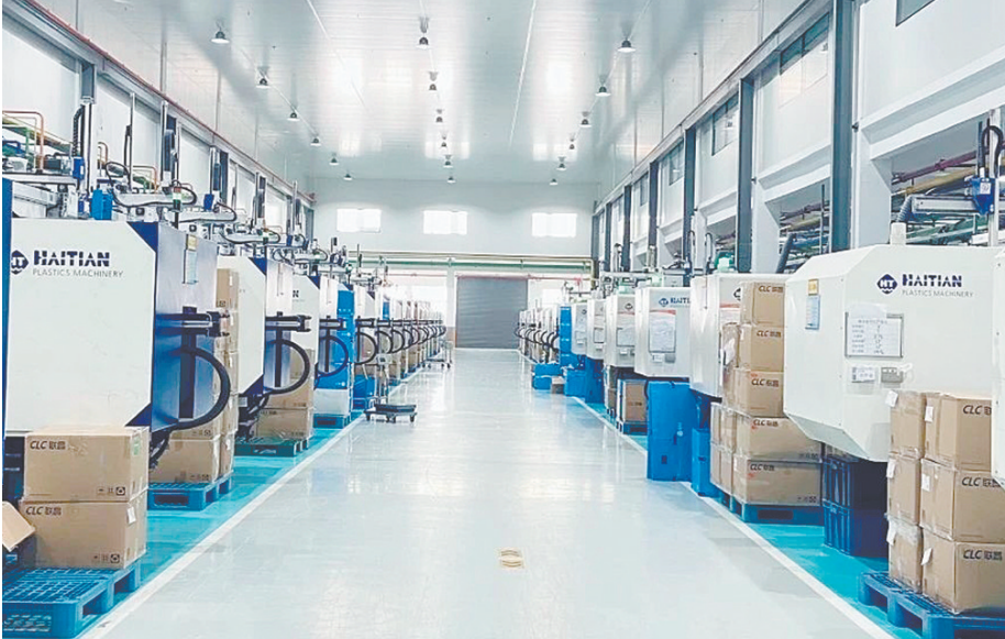
联昌喷雾泵(鹤山)有限公司致力于打造国内最大的喷雾泵生产基地。图为项目一期已投产生产车间。
