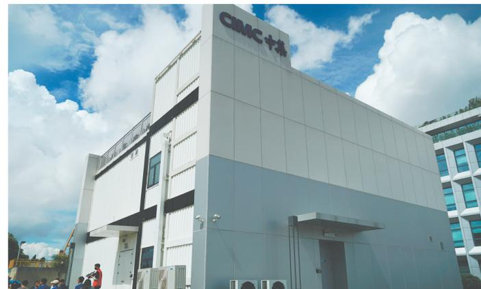
中集以模块化设计改变建筑模式。图为由集装箱模块搭建起来的数据中心建筑。郭永乐 摄
