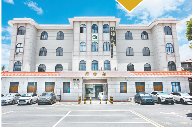
古劳镇卫生院经过改造，环境设施、医疗设备、服务水平等方面得到全面升级。
