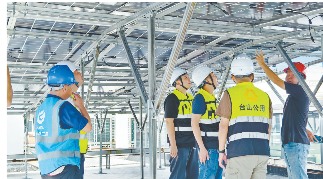
工作人员加快推进光伏项目建设。
