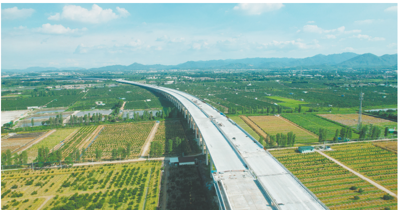
TJ03标深湛铁路跨线桥右幅17#墩最后一块预制箱梁完成精准架设。
