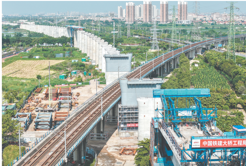
钢墩柱吊装作业的圆满完成,为钢桁梁上跨广珠城际铁路施工奠定基础。
