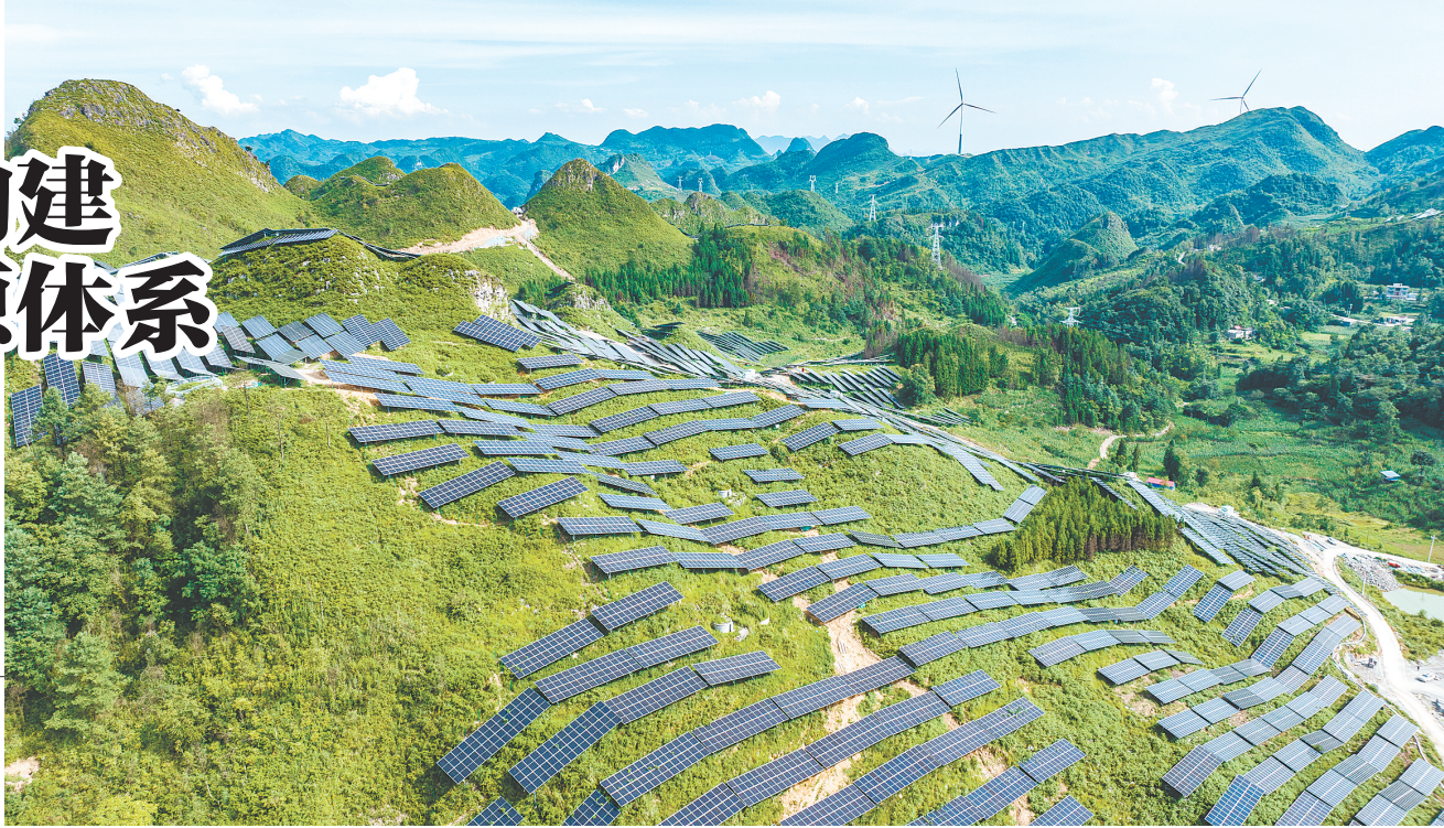
图为中国安能集团第一工程局承建的六盘水市水城区陡箐农业光伏电站一隅(7月17日摄，无人机照片)。 新华社发
