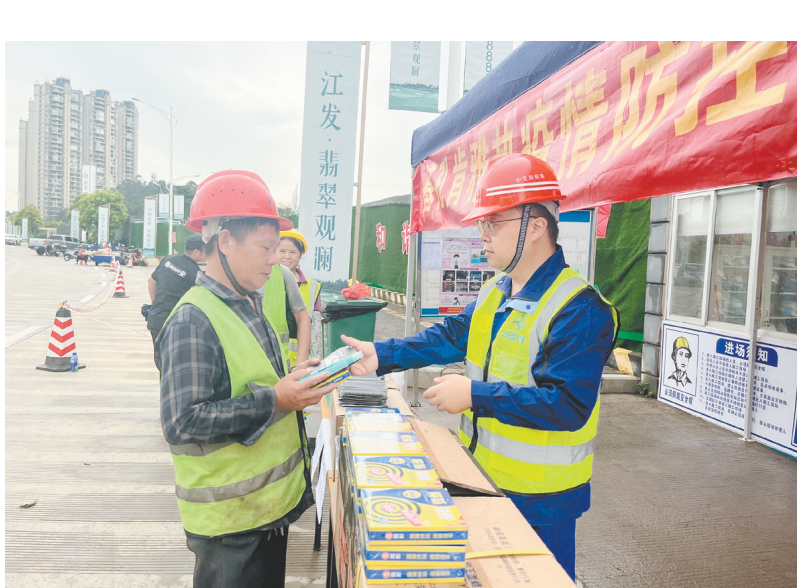
工地施工人员排队领取防蚊用品。
