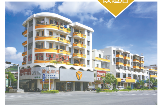
址山镇对圩镇超90栋房屋外立面统一采用岭南传统建筑风格进行提升改造。
