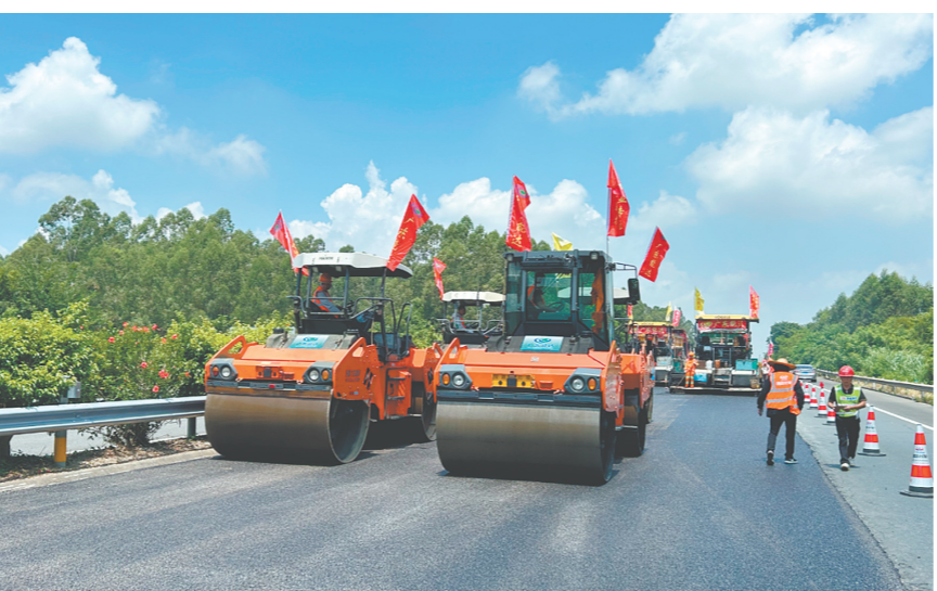
在摊铺施工现场,多台工程机械有序作业。 广东交通集团供图
