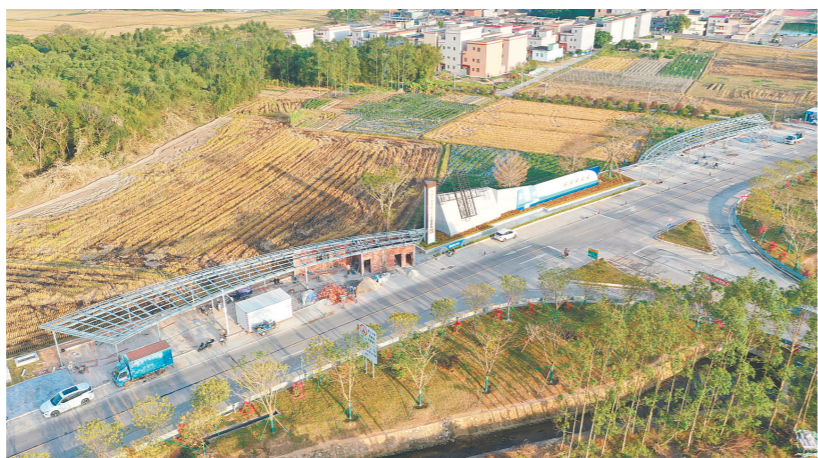
位于牛江镇高速出入口,集省道驿站、超充停车场于一体的新综合体,正在搭建钢结构。
