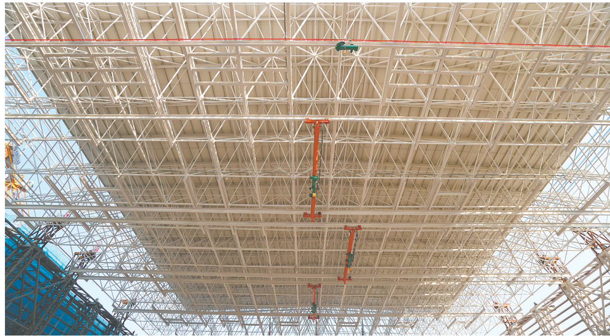
本次吊装的阀厅网架重达1032吨,面积相当于一个标准的足球场。
