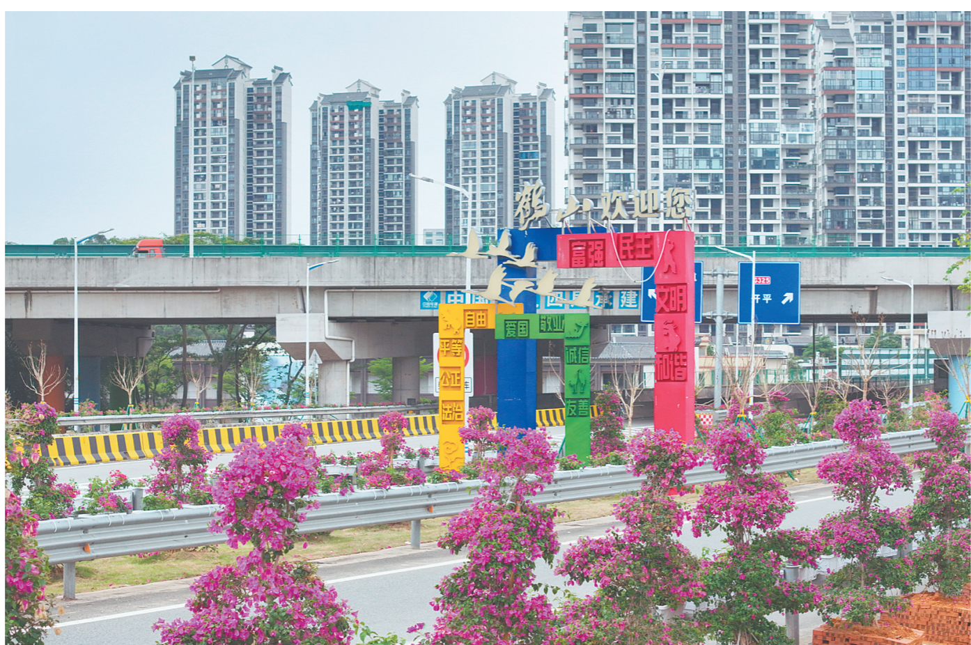
整治后的大雁山高速出入口。
