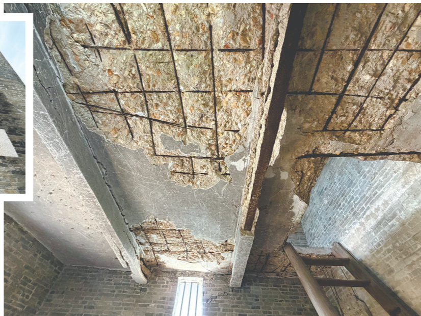
图南楼内部可清晰看见钢筋混凝土结构。
