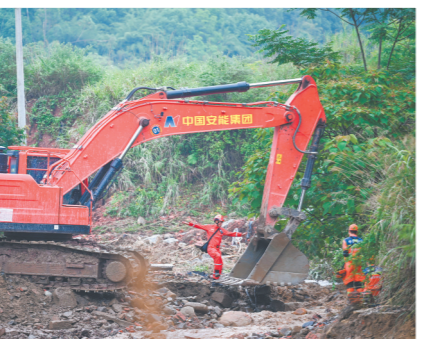
大型挖掘机现场作业。新华社发
