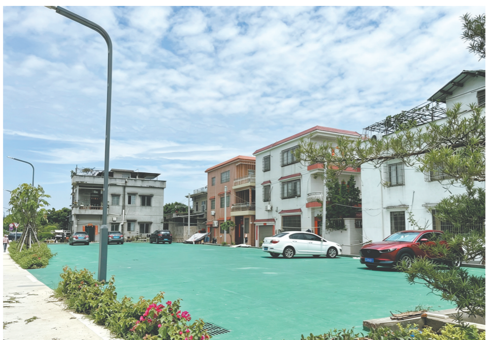
潮连街道多冈社区岐山村小组对村口蚊虫孳生地进行整治,改建为停车场。
