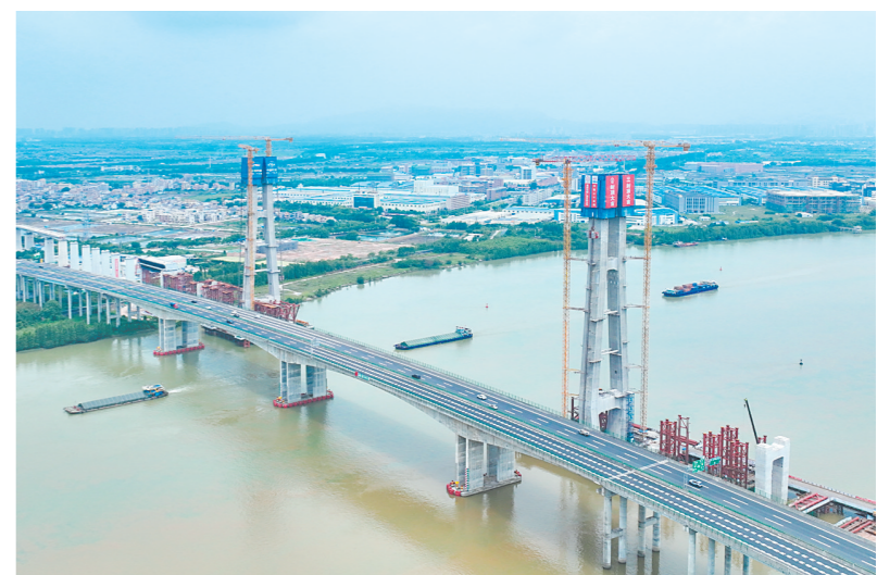
广中江特大桥跨虎跳门水道斜拉桥施工现场。
