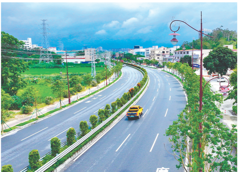
鹤山市扎实推进绿美交通建设,让道路四季有景、步步见绿。冯铭军 摄
