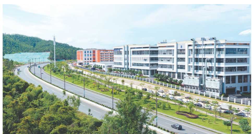
立足区域产业禀赋,八镇正推动水暖卫浴等传统产业协同发展,实现绿色化、集约化升级。图为开平市国际卫浴创新基地。
