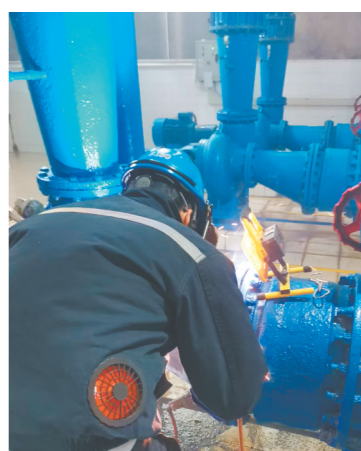
工作人员对水厂制水设备开展维修保养。
