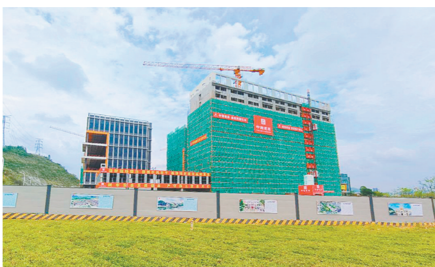
银湖·大泽装备园项目建设安装了规范统一的装配式围挡。
