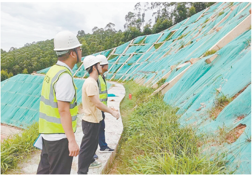
经过数月有序施工,目前大江镇大巷村渡头新区马山脚地质灾害隐患点边坡防护治理工程建设已基本完工。
